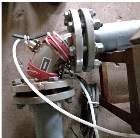
图7 DN80耐腐蚀弯管流量计在现场的安装
